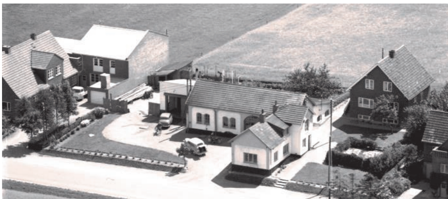
Kværndrup Andels-elektricitetsværk, 1959. SJ Luftfoto
