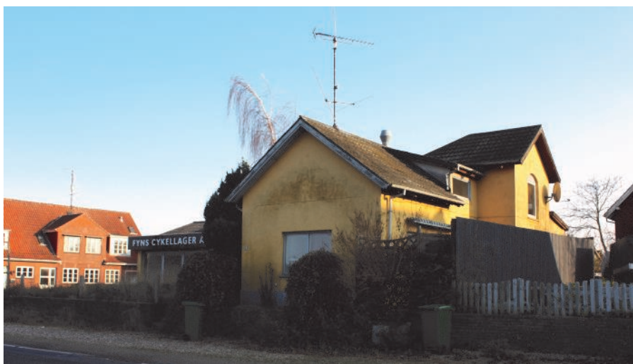
Ejendommen Nyborgvej 31. Foto: Edvin Larsen, 2011.
