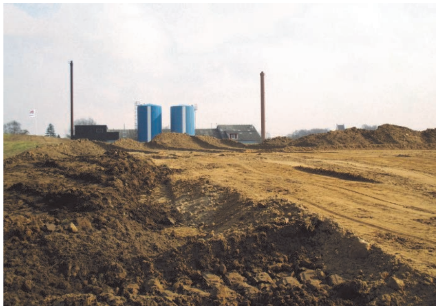
Etablering af solfangerområdet, 2015. Foto: Kværndrup Fjernvarme
