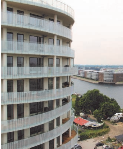
Istårnet på Islands Brygge i København, hvor Alusteel har lavet vænet rundt ved altanerne
