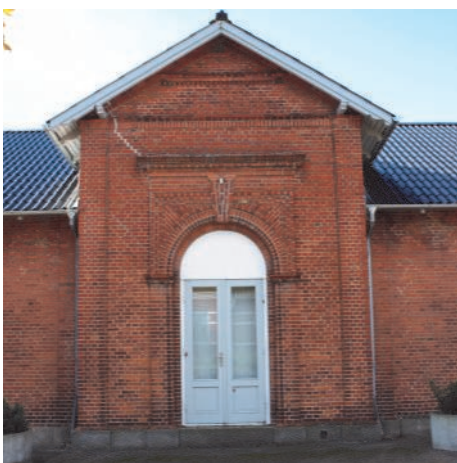
Husets oprindelig indgang. Foto: Edvin Larsen, 2011
